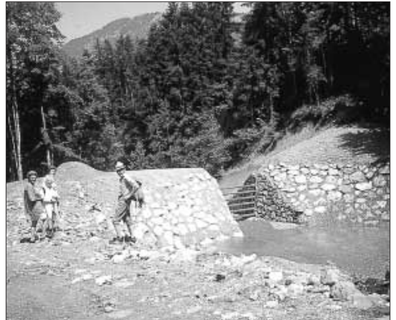
Die Geschiebesperre des Eifersbachs nach der Regulierung 1993.
