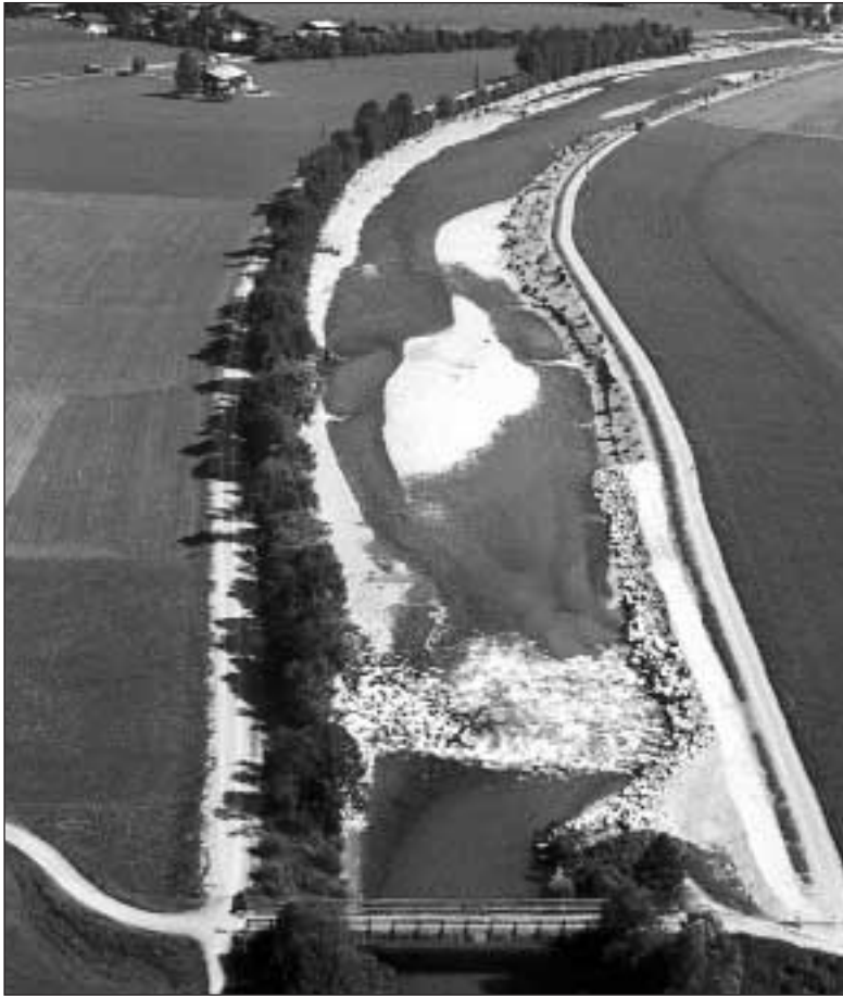
Auf dem Bild erkennt man die Großache vom Furthesteg flussabwärts. Unterhalb des Steges befindet sich die Sohlstufe, die nach Abschluss des nächsten Projektabschnittes bis herauf zum "Achenzipf" angehohen wird.
